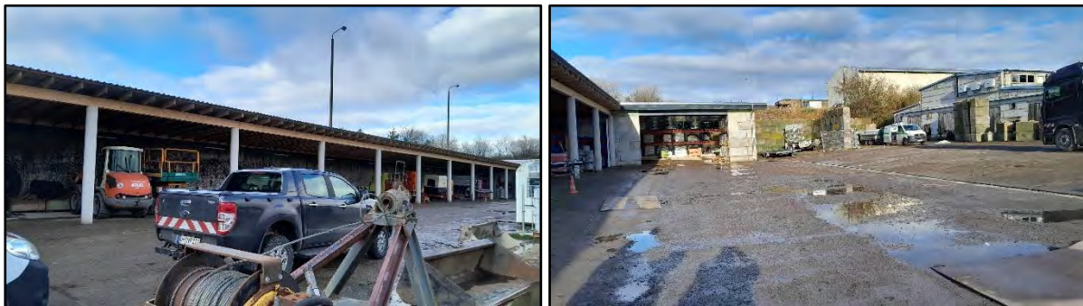
Abbildung 3: offene Halle für Baumaschinen (l.), geschl. Halle Baumaterial (r.)
