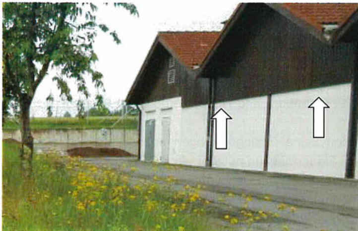
Abb. 8: Holzverschalung - ohne Anzeichen für Fledermausquartiere (Kotspuren)
