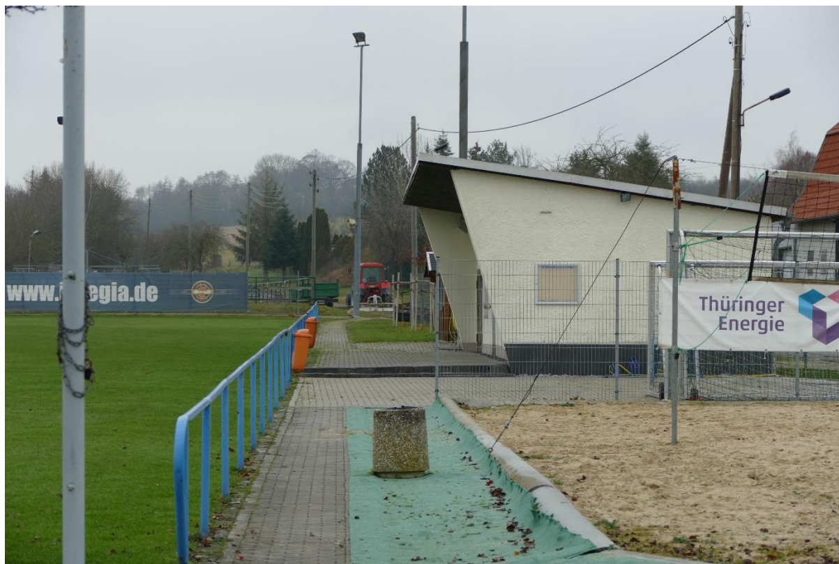
Abbildung 110: Bestandssituation Altes Sportlerheim Silberhausen (Quelle: ProjektStadt 2021)
