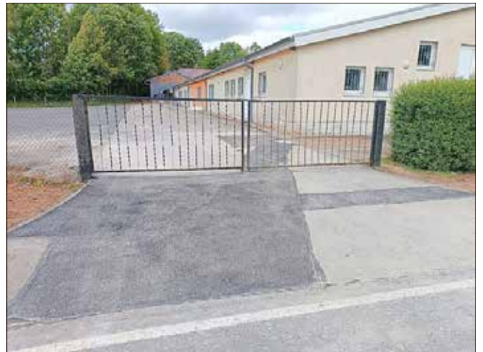
Die Gesamtkosten der Sanierung belaufen sich auf 159.018,87 €, die vollständig aus Eigenmitteln finanziert wurden. Mit dieser Investition wird die Festhalle nicht nur technisch auf den neuesten Stand gebracht, sondern auch langfristig als zentraler Treffpunkt der Ortschaft Struth gesichert.
