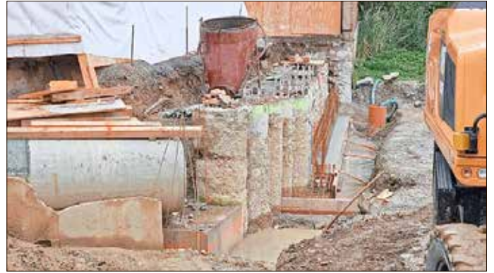
Bohrpfahlwände
