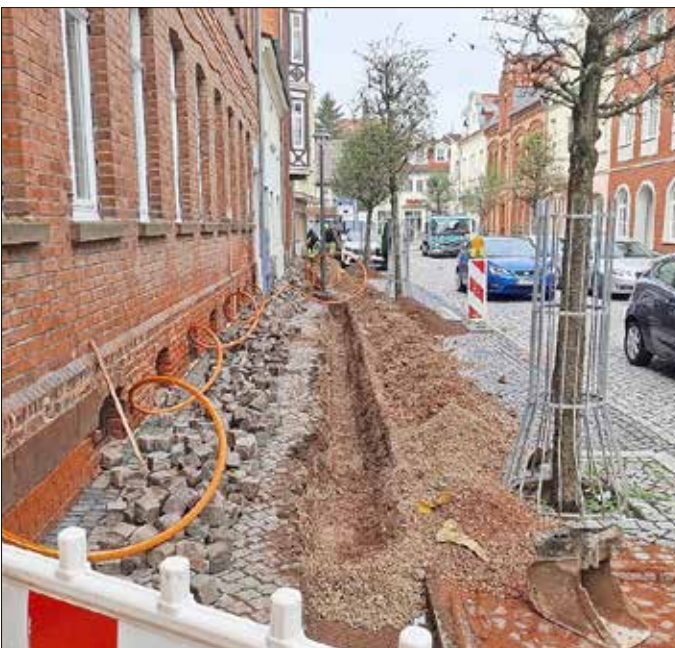
Glasfaserausbau 2024 in der Geschwister-Scholl-Straße
