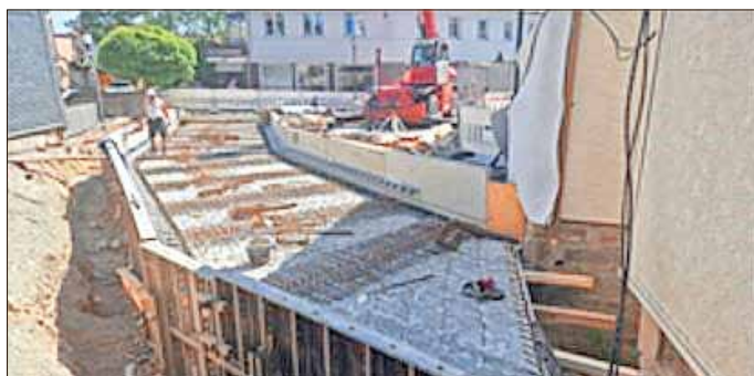
Die Sanierung sorgt nicht nur für eine Verbesserung der Verkehrssicherheit, sondern trägt auch für einen verbesserten Hochwasserschutz bei.
