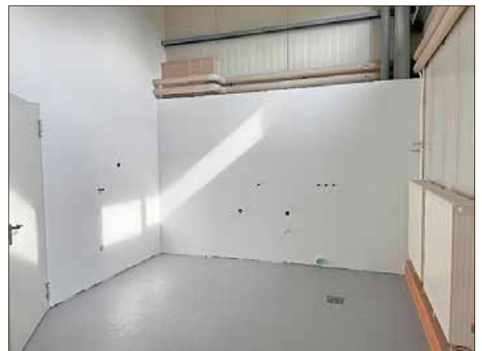
Die Gesamtkosten des Projekts betragen 88.431,66 Euro und werden vollständig durch den Eigenanteil der Stadt Dingelstädt finanziert.
