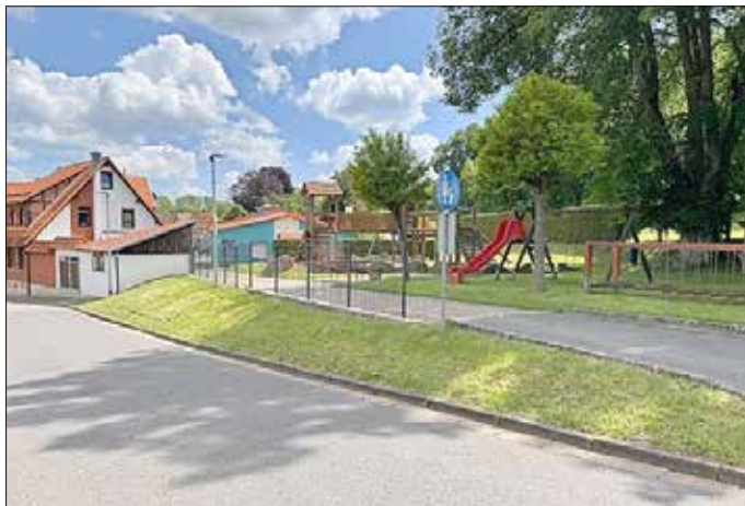
Erneuerung Geländers zum Spielplatz
