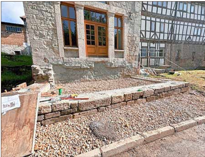
Wiedererrichtung der Terrasse: Eine Außentreppe sowie eine Natursteinbalustrade werden originalgetreu nachempfunden.
