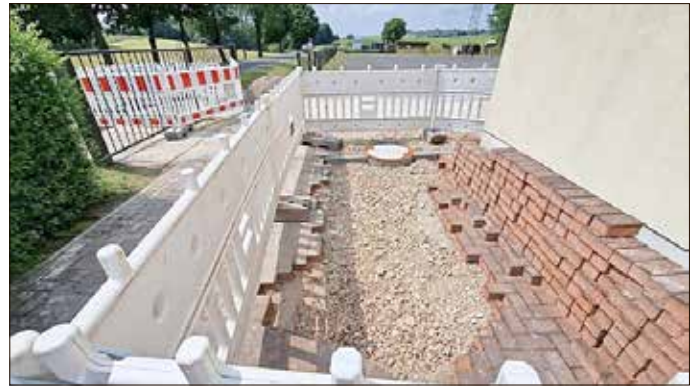
Erneuerung der Drainage: Rund um das Gebäude wird die gesamte Drainage, inklusive der Drainageschächte, erneuert und an den bestehenden Regenwasserkanal angeschlossen.
