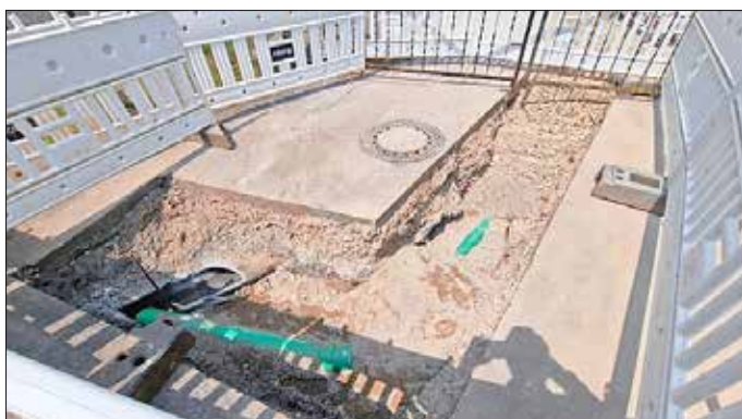
Still-Legung der alten Klärgrube: Die veraltete Klärgrube wird außer Betrieb genommen.
