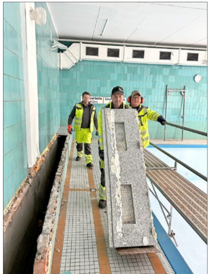
Kollegen des Bauhofes bei der Arbeit im Schwimmbad in Dingelstädt
