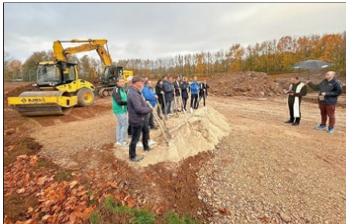
Die Bagger stehen schon, die Bauarbeiten beginnen.
