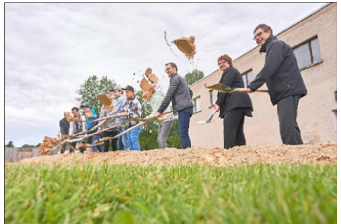
Spatenstich für den Neubau unseres Hallenbades
